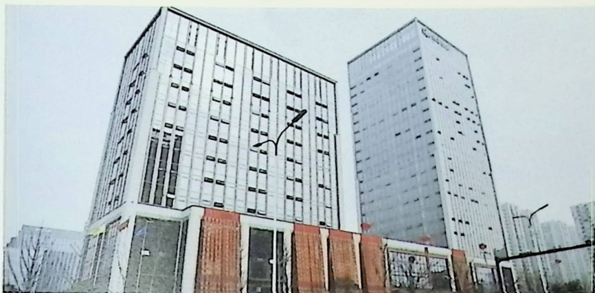
项目名称 浙水股份科技大厦
