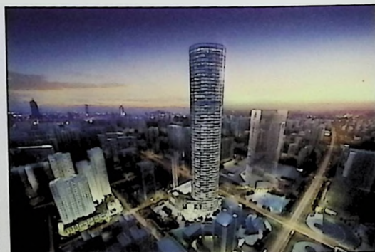
Qingdao Shipping International Center 青岛航运国际中心
