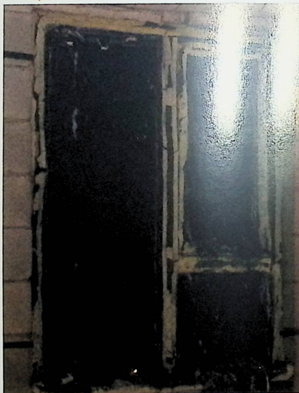
乙级防火窗检测烧检结束向火面实拍
