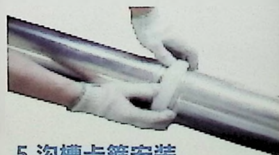
5.沟槽卡箍安装
