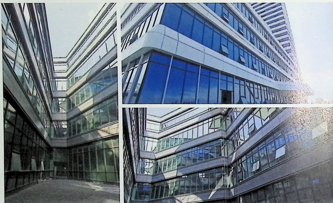
▲ 中山大学第一附属(南沙)医院 | 防火玻璃幕墙
