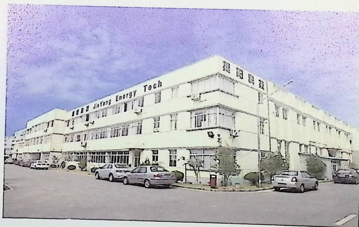
捷阳厂区-B区
