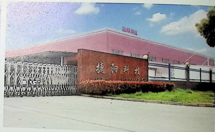
捷阳厂区-C区
