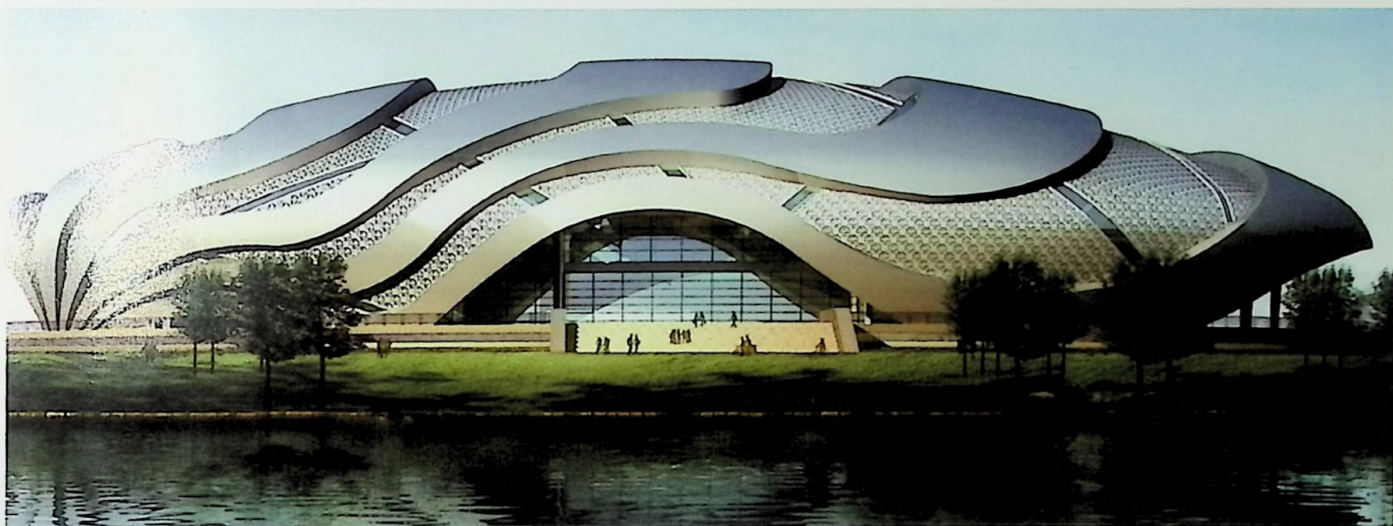
◆ 亚运会重点工程 —— 广州自行车馆 The Asian Games Project 2010 —— Bicycle Gymnasium Center
