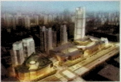
项目名称：上海大悦城 产品：智能型电动内置中空百叶玻璃 完工日期：2017年年底
